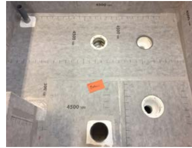
Test av tätskikt 2022
