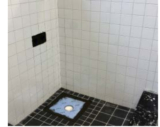
Delreparation av badrum
