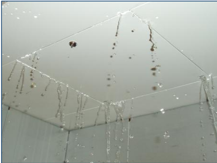
Fordelerskap montert i himling
