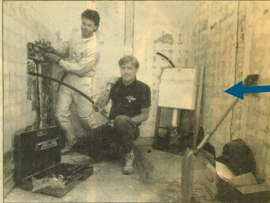
Pilotprosjektet med våtromsnorm utprøves på Røa. Full rehabilitering av to bad og et våtrom for varmtvannsbereder er kalkulert til 160 000–170 000 kroner. Hovedentreprenør er rørlegger Thomas Larsen (t.h.) mens Calle Andersen står for murerarbeidet. Neste gang er det kanskje mureren som er hovedentreprenør.
